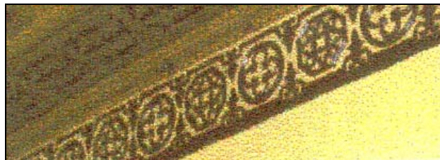
Gambar 10. Gypsumboard pada bagian atas dinding hall sembahyang
