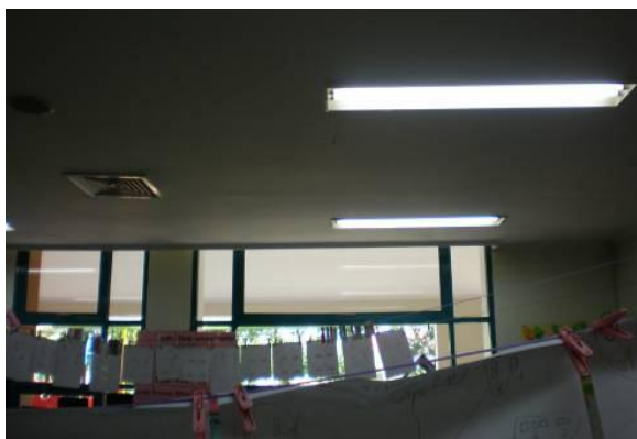
Gambar 4. Plafon ruang kelas
